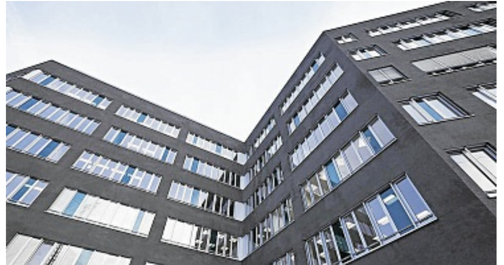
Die Fassade ist als Wärmedämmverbundsystem nach dem Spar-Dash-Verfahren ausgeführt.
